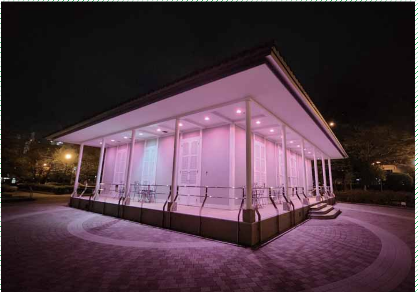
第1グループ <ピンクリボンよこすか2023でライトアップされたティボディ邸> 1869年(明治2年)に建築された本州で最古級の西洋館(横須賀製鉄所副首長邸)
